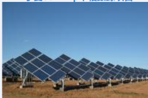
宁夏60MWp单轴跟踪项目
