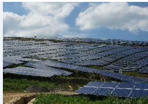
贵州兴义150MWp农光互补项目
