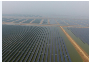
通威滨州300MW渔光互补项目
